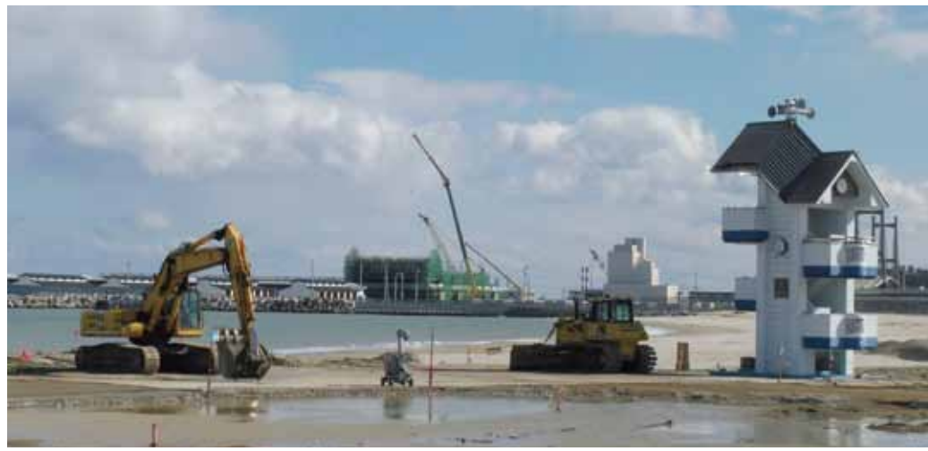
▲砂浜を整地するための重機
