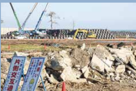
▲JR富岡駅の近くにある廃棄物の仮置き場
